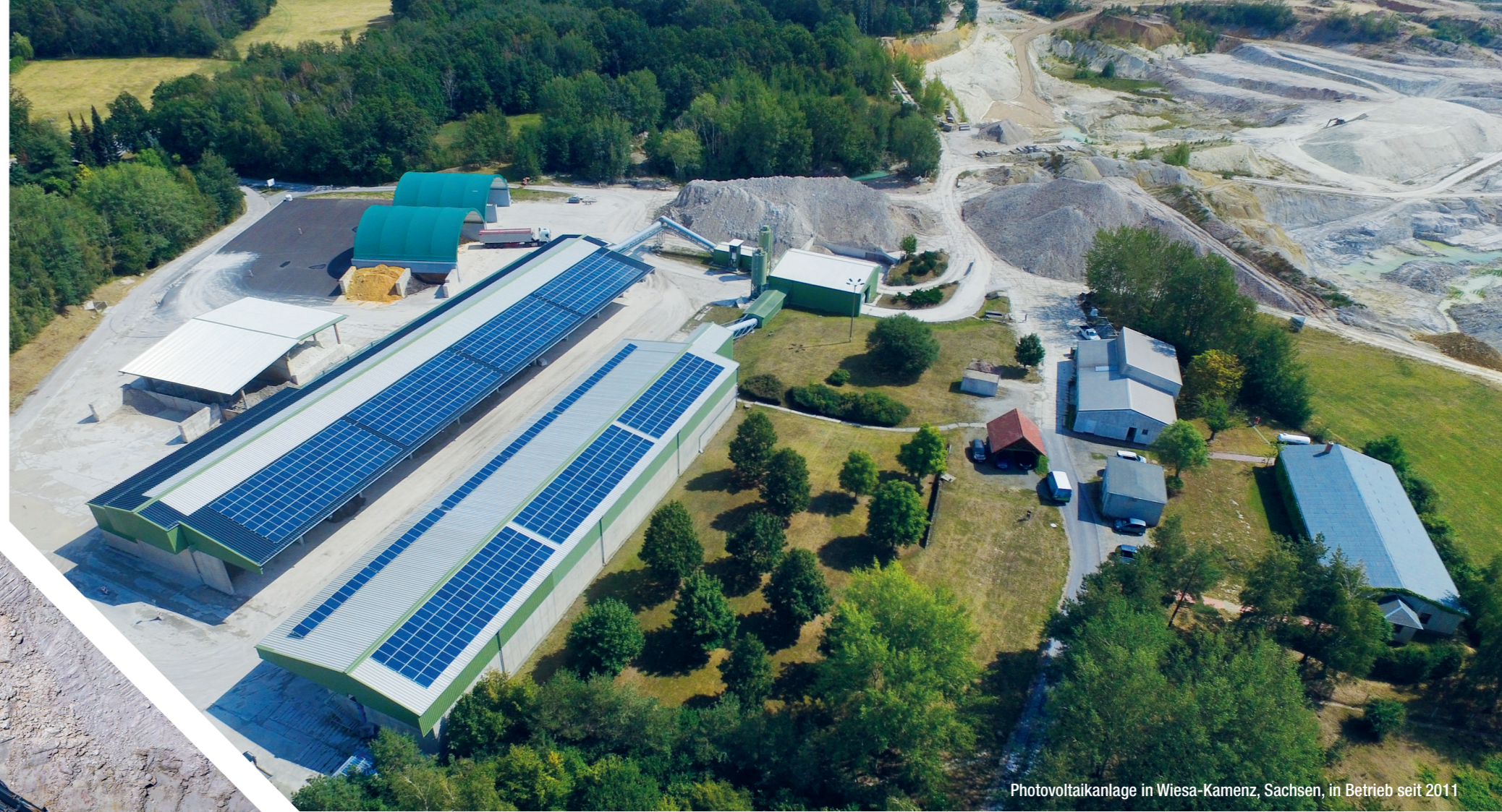
Bereits seit den 1980er-Jahren in Betrieb: Bandförderanlage der Grube Wimpfsfeld
